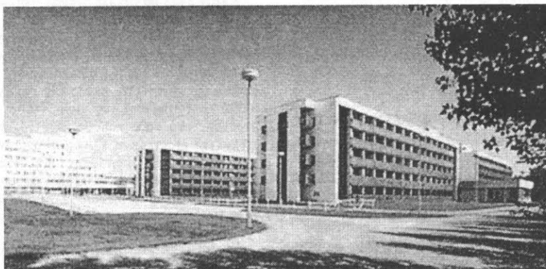
Účelové zariadenie Gabčíkovo
